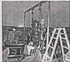
一部解体し、 滑車でつり上げ、
