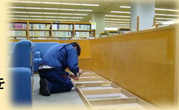
ソファを外し、カーペットを張り替えます
